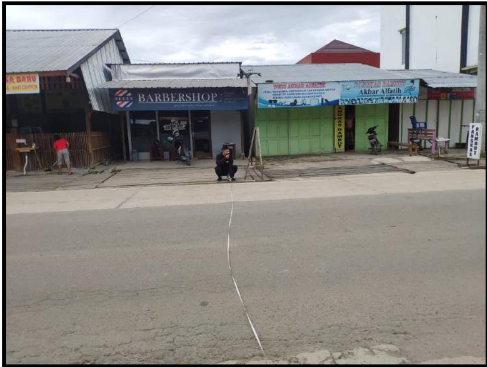
Gambar 7. Pengukuran geometri lebar jalan
