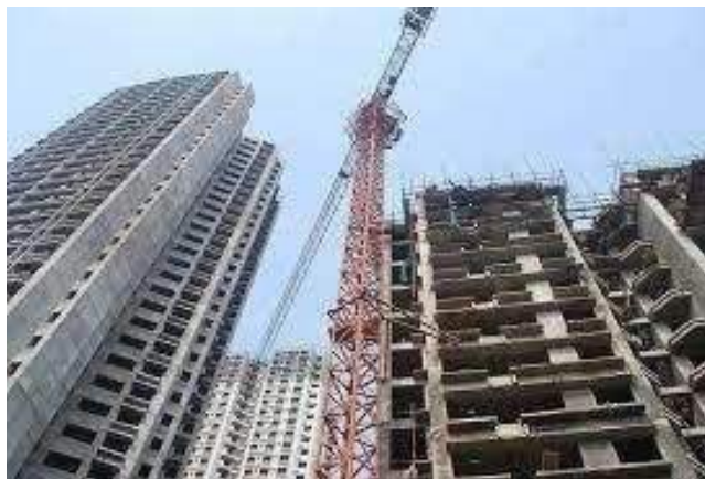
Gambar 4.18. Struktur Bangunan Tinggi Sumber : (Google, 2021)
