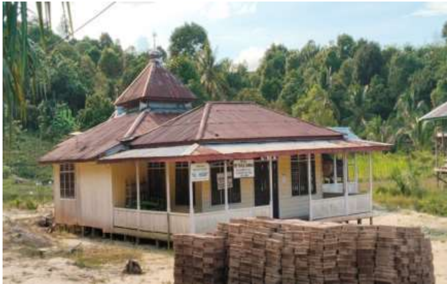
Gambar 6. Fasilitas ibadah (Masjid) di SP7 Desa Salimbatu
