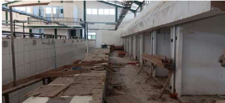
Gambar 4. 3 Kondisi Pasar Rayat
