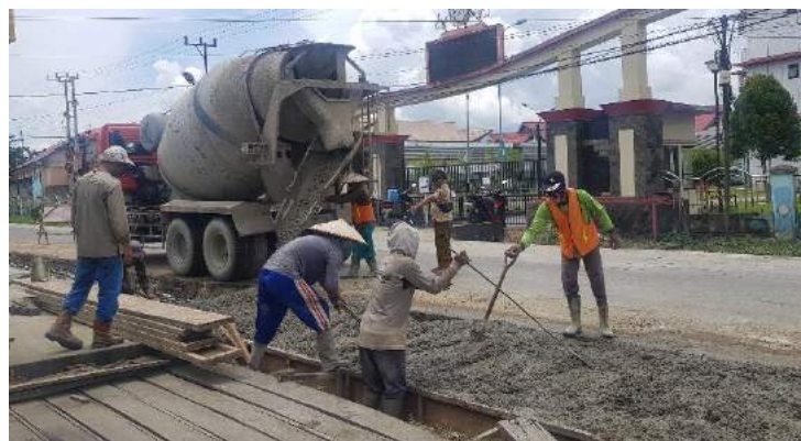
Pengecoran rigid di titik 2
