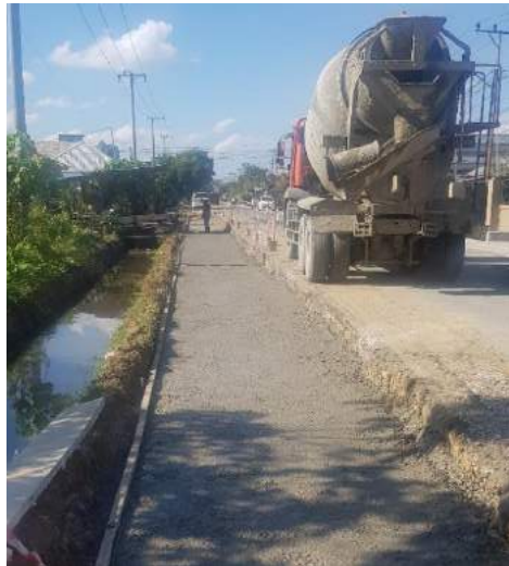
Pengecoran LC pada titik 1
