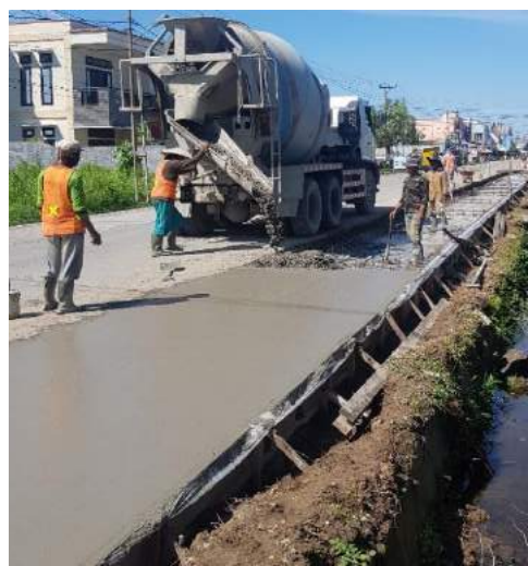
Pengecoran rigid pada titik 1
