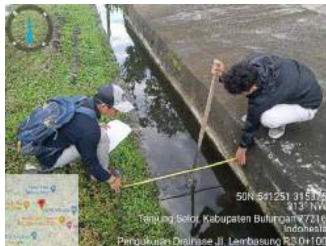
Pengukuran Dimensi Saluran STA 0+100
