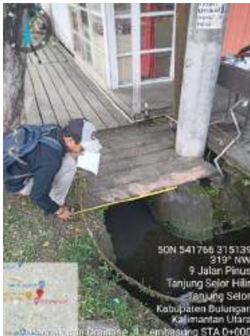
Pengukuran Dimensi Saluran STA 0+000 (Persimpangan Durian)
