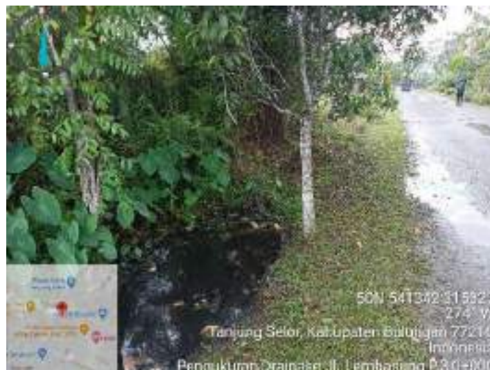
Gambar 4.4 Saluran Eksisting Tertutup
