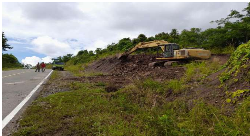
Gambar 3.3 Excavator (PT. Cahaya Baru Prima)
