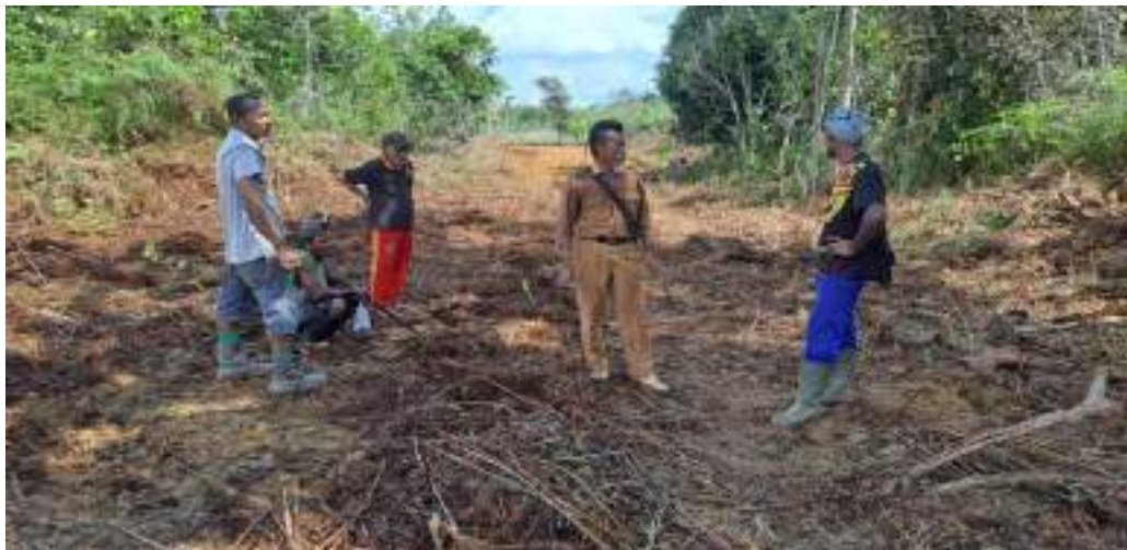
(Dokumentasi pembangunan jalan usaha tani)
