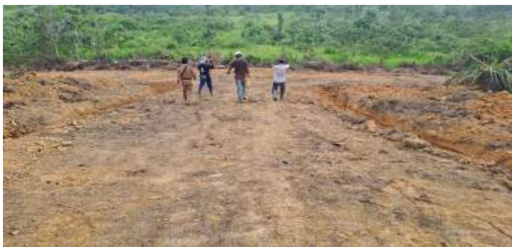
(Dokumentasi pembangunan jalan usaha tani)
