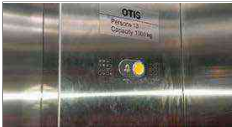
Tombol Alarm Darurat Dalam Lift
