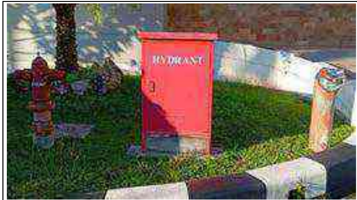
Hidran Halaman Dan Siames Connection Berada Di Halaman Depan
