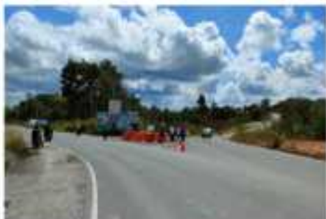
Dokumentasi Eksisting Jalan Mayat Tanjung Selur - Tanjung Redah - Tanah Kuning
