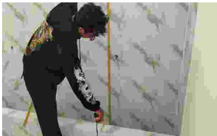
Gambar 4. 16 Dokumentasi pengukuran pekerjaan dinding tempat wudhu
