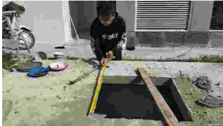
Gambar 4. 13 Dokumentasi pengukuran dimensi pekerjaan Ground Water Tank
