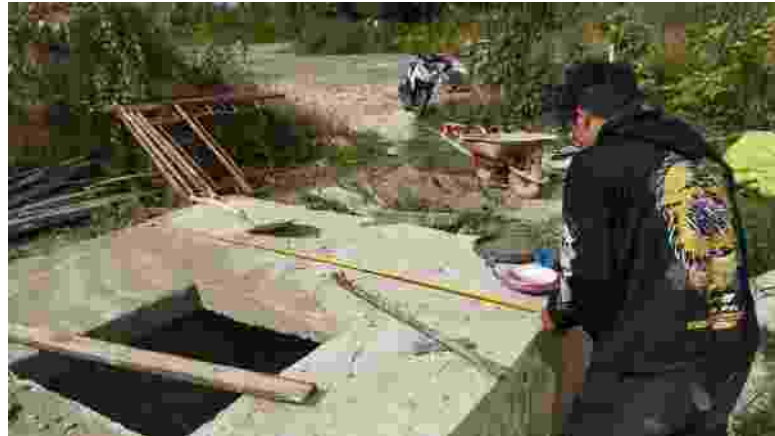
Gambar 4.4 Dokumentasi kesesuaian dimensi pekerjaan Ground Water Tank
