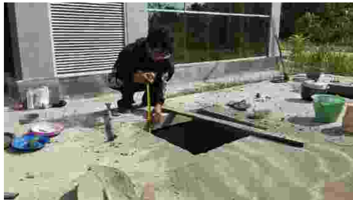
Gambar 4. 12 Dokumentasi pengukuran dimensi pekerjaan Ground Water Tank
