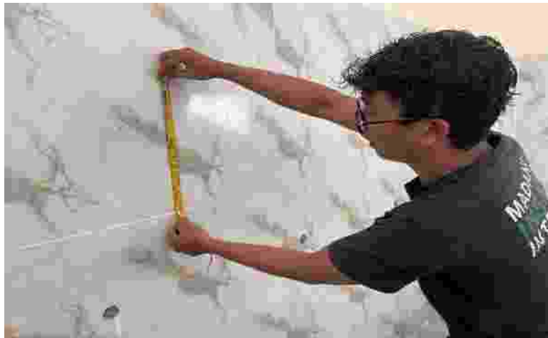
Gambar 4.3 Dokumentasi kesesuaian dimensi pekerjaan keramik tempat wudhu
