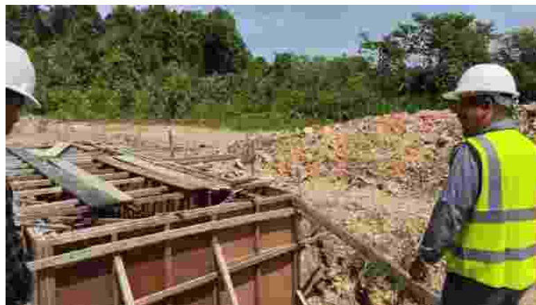
Gambar 4.7 Dokumentasi pemeriksaan item pekerjaan sebelum dilanjutkan ke tahap selanjutnya.
