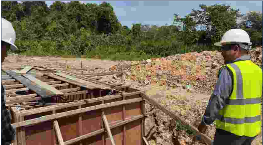
Dokumentasi pemeriksaan item pekerjaan sebelum dilanjutkan ke tahap selanjutnya
