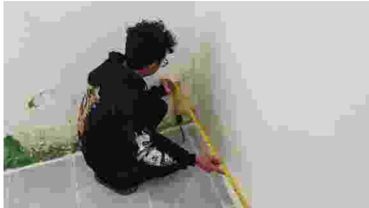
Gambar 4.15 Dokumentasi pengukuran pekerjaan dinding tempat wudhu
