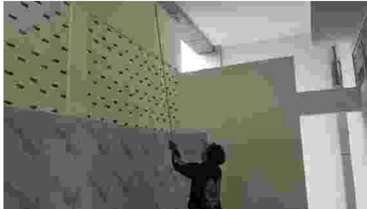
Gambar 4.17 Dokumentasi pengukuran pekerjaan dinding tempat wudhu
