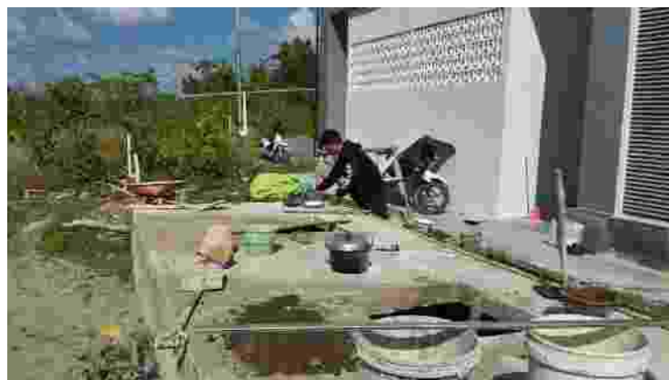
Gambar 4. 14 Dokumentasi pengukuran dimensi pekerjaan Ground Water Tank
