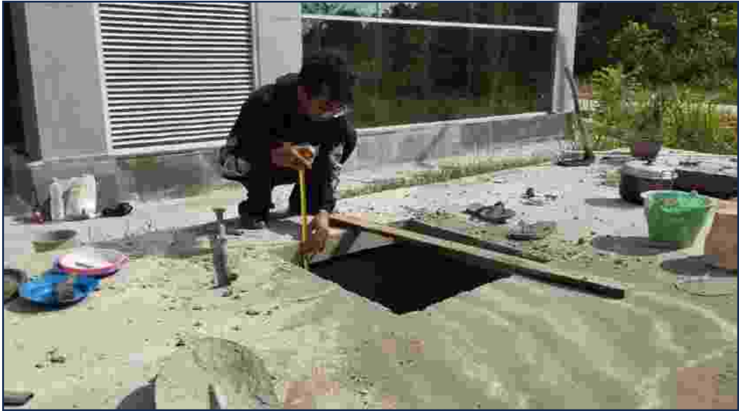
Dokumentasi pengukuran dimensi manhole pada ground water tank
